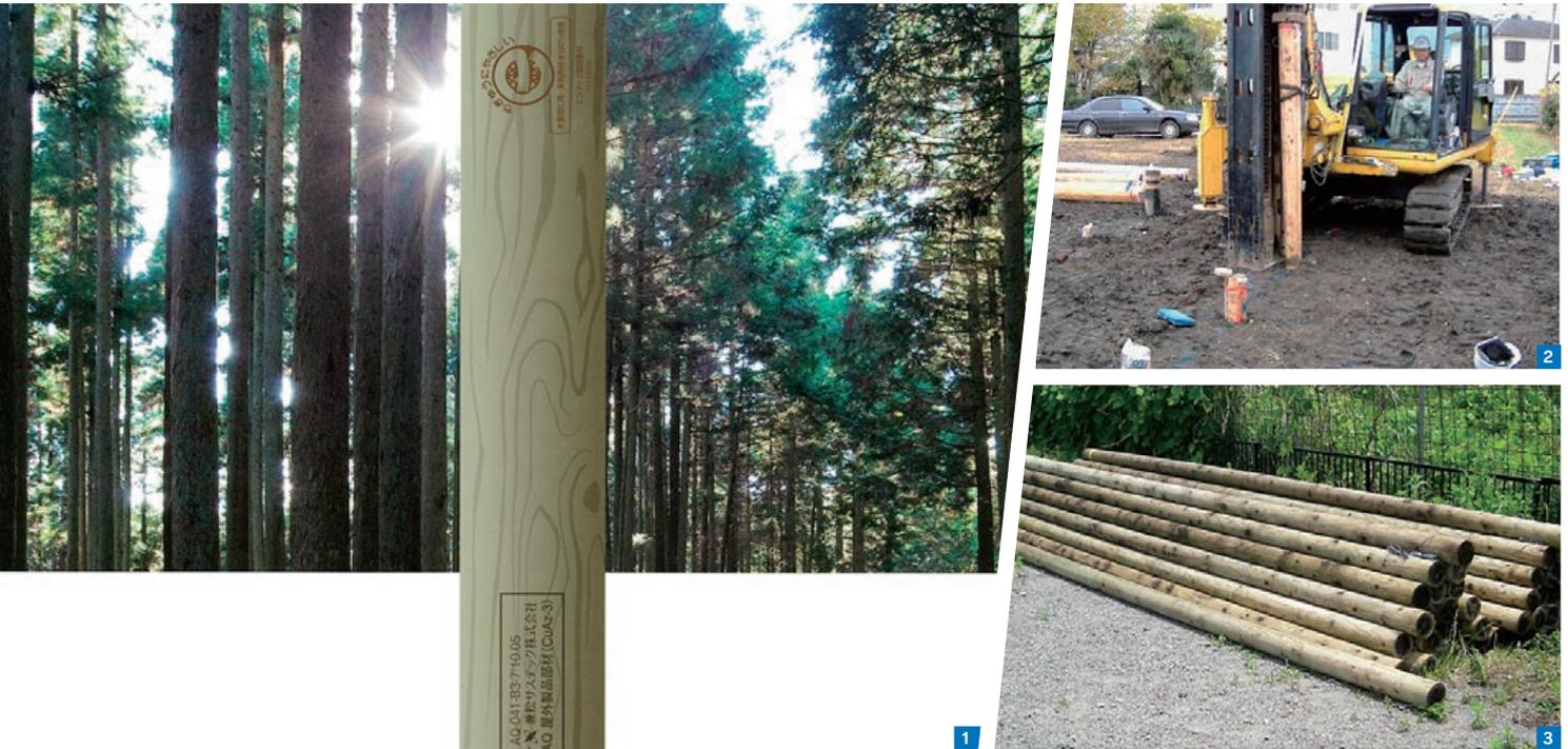
1.3.防腐・防蟻処理木材(国産) 2.圧入力型専用重機にて無回転圧入
