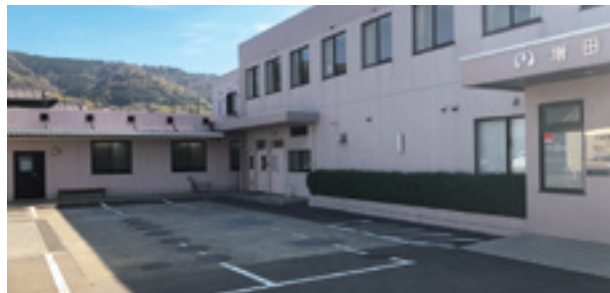
SCT型施工例〔愛媛県〕
