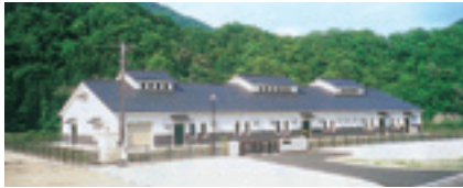
桜江中央地区農業集落排水処理施設 〔島根県〕 処理水量 864m 3 /日
