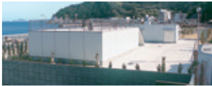
魚島村コミュニティ・プラント 〔愛媛県〕 処理水量 190m 3 /日
