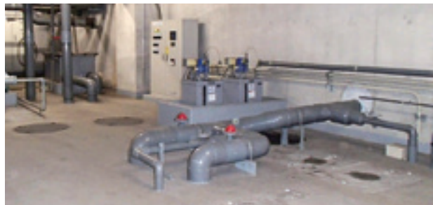
CT型施工例〔東京都〕
