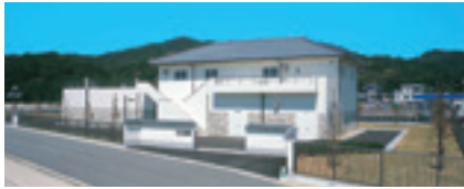
西沢町 阿那賀漁業集落排水処理施設 〔兵庫県〕 処理水量 267m 3 /日
