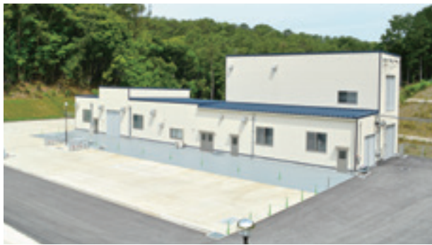
北薩広域行政事務組合環境センター最終処分場〔鹿児島県〕処理水量100m 3 /日
