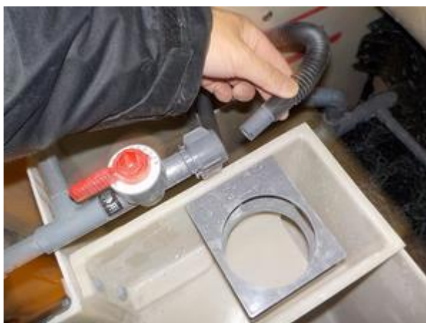
④洗浄管を上を持ちあげ、槽外へ引抜く
