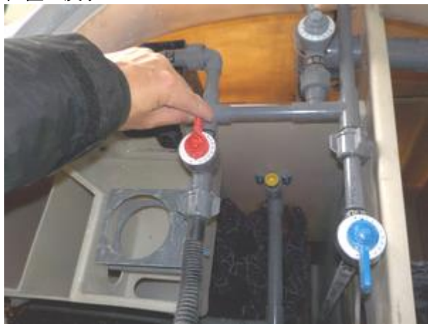
⑥上記の逆の手順にて配管を復旧し、バルブも元の位置に戻す
