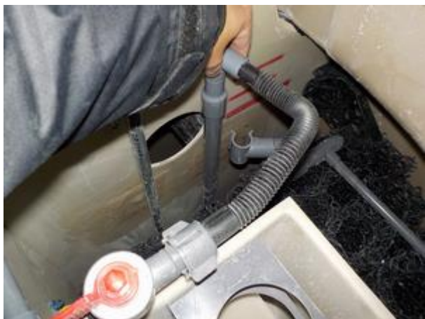
③洗浄管を時計回りに回転させる
