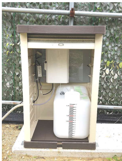
正面（シャッター開時）
