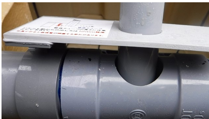
PAC 移送チューブ導入ホース固定具部品 固定状況
