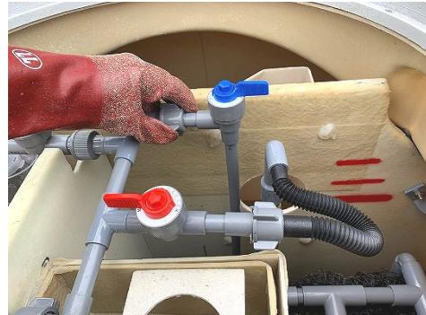
2. 散気管を上方方向へ持ち上げ、散気受けから外す。
