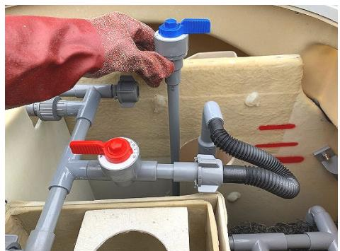
3. 作業後は、散気管を仕切板に沿わせて下方向に押し込み、散気受けに収める。
