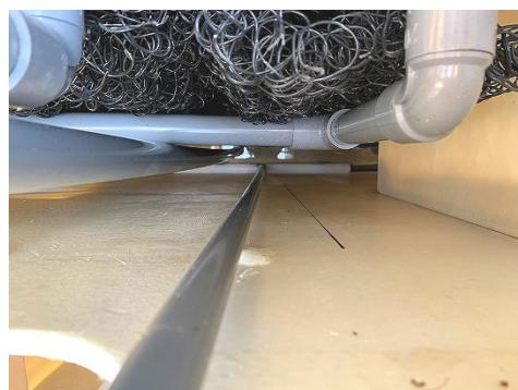
※実現場では槽内水がありますが、仕切板に沿わせて押し込めば散気受けに収まります。
