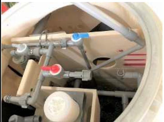
②送気管のユニオンを落とさないように注意しながら緩め、配管を抜く
