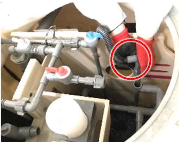
⑥上記の逆の手順で洗浄管を復旧し、バルブも元の位置に戻す
