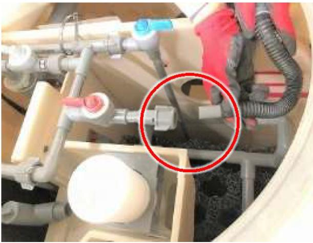
⑤引抜いた洗浄管をブラシ・圧水等によって洗浄する
