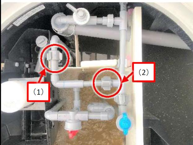
④ろ材洗浄用バルブ(赤)のレバーを【放流側】に向け、洗浄管(固定)を圧水洗浄する
