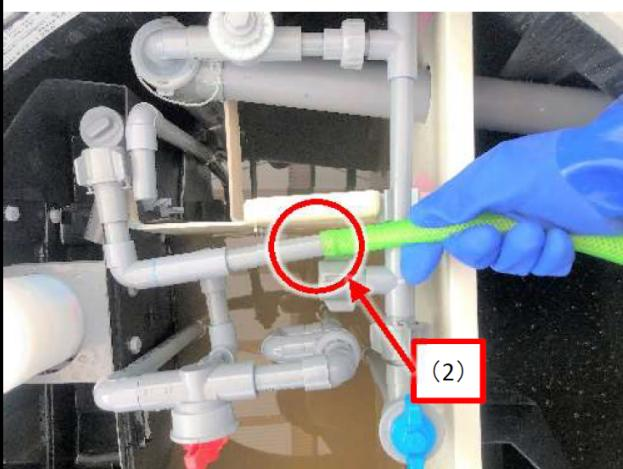
⑤ろ材洗浄用バルブ(赤)のレバーを【流入側】に向け、洗浄管(可動)を圧水洗浄する
