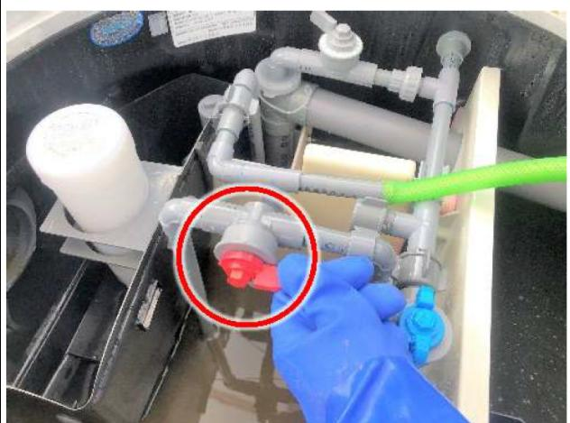
③引抜いた配管(1)を元に戻し、ユニオンを締める
