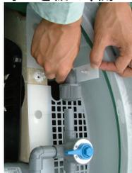
④散気管を散気管ホルダーから外し、槽内から取り出す。
