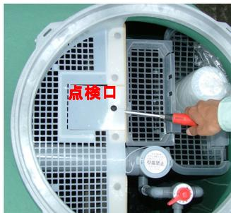
⑧点検口から担体流動槽内へ DO 計を挿入し、DO を測定する。
