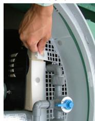
洗浄しても改善されない場合は散気管を交換する。
