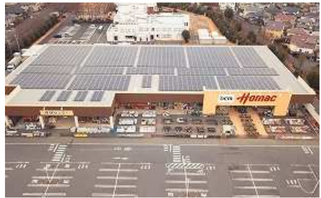
d)ホームックつくばみらい店(400kW 茨城県つくばみらい市 2019/1 連系)
